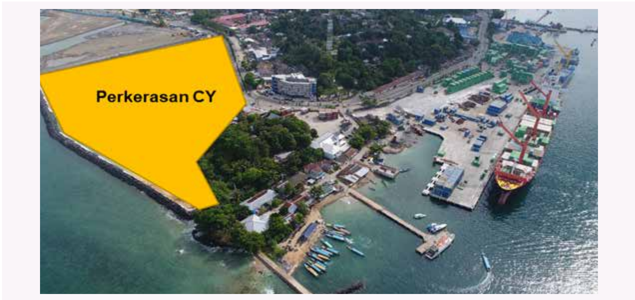
I.25 Pekerjaan Pelabuhan Sorong dan Arar
