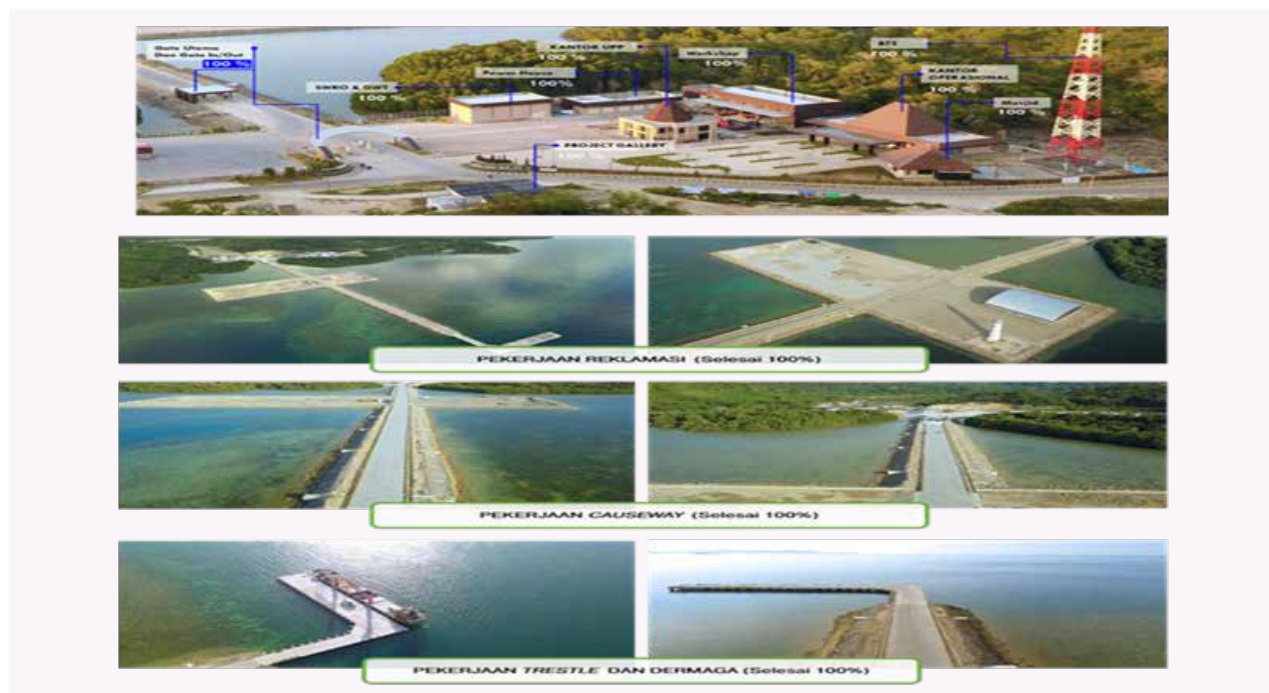
Gambar Pembangunan Terminal Multipurpose Labuan Bajo Construction of the Labuan Bajo Multipurpose Terminal
