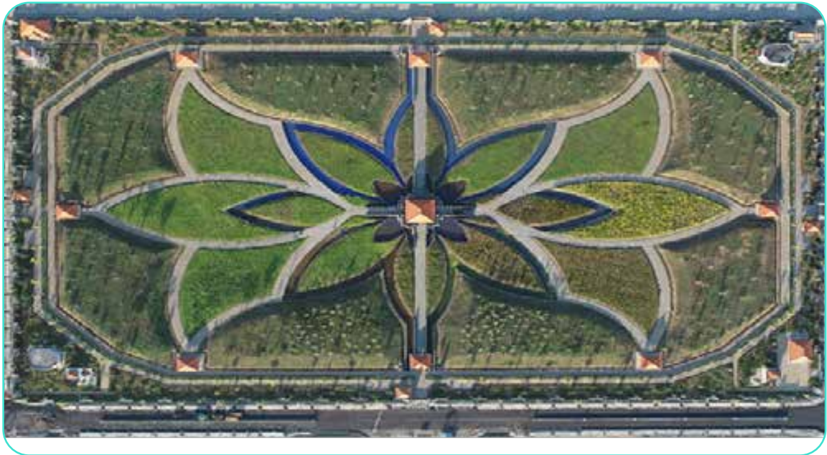
Gambar Dokumentasi Pekerjaan Pembangunan Taman Segara Kerthi Area Pengembangan I Segara Kerthi Park Construction Work Development Area I Documentation
