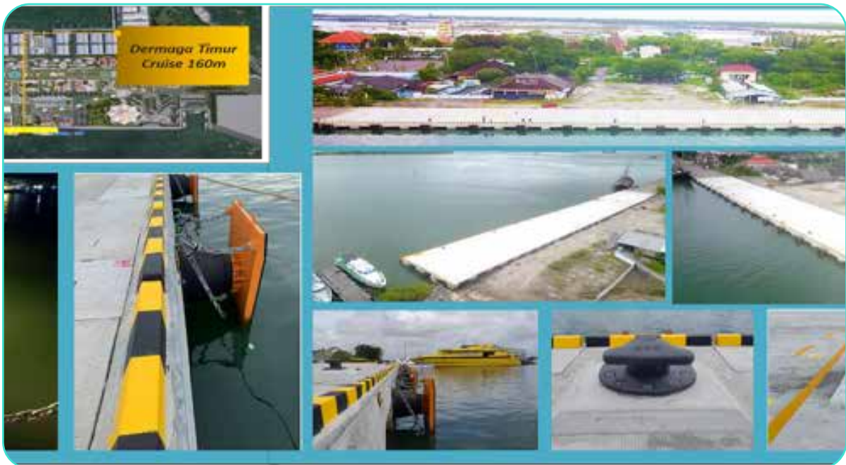
Gambar Dokumentasi Pekerjaan Perpanjangan Dermaga Cruise Sisi Timur 160 m 160 m East Side Cruise Wharf Extension Works Documentation
