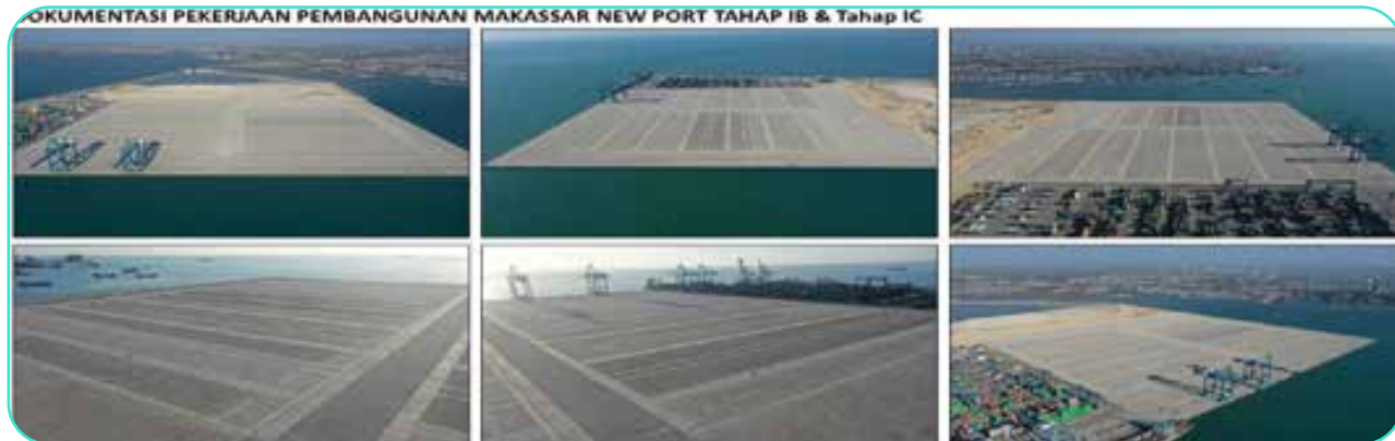
Gambar Dokumentasi Progres Pembangunan Makassar New Port Tahap 1B dan 1C Progress Construction of Makassar New Port Phase 1B and 1C Documentation
