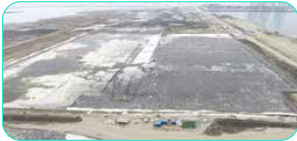
Gambar Pekerjaan Pengadaan dan Penghamparan Pasir Procurement and Sand Laying
