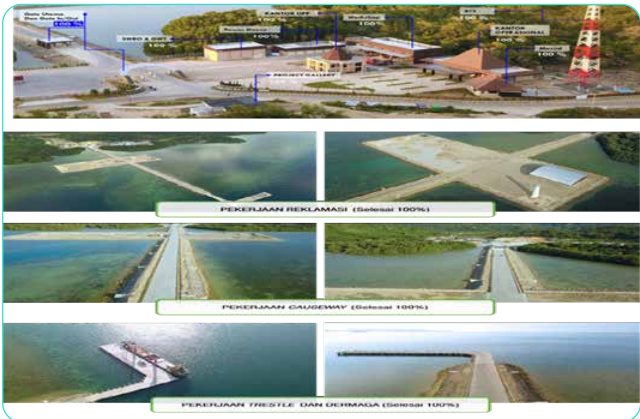
Gambar Dokumentasi Pembangunan Terminal Multipurpose Labuan Bajo Construction of the Labuan Bajo Multipurpose Terminal Documentation
