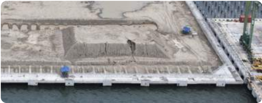
Gambar Pekerjaan Konstruksi Dermaga Pier Construction Work
