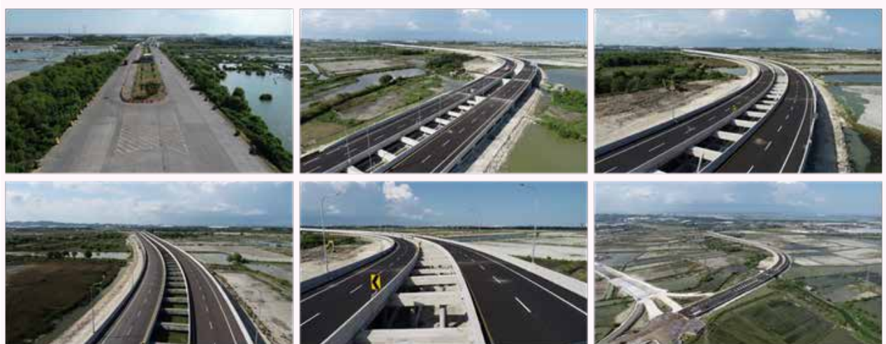
Gambar Pembangunan Fly Over dari dan Menuju Terminal Teluk Lamong Construction of Fly Over from and to Teluk Lamong Terminal
