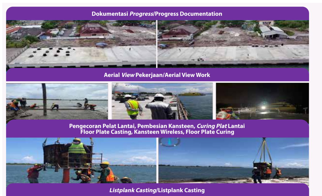
Gambar Dokumentasi Pekerjaan Perpanjangan Dermaga Cruise Sisi Timur 160 m 160 m East Side Cruise Wharf Extension Works Documentation
