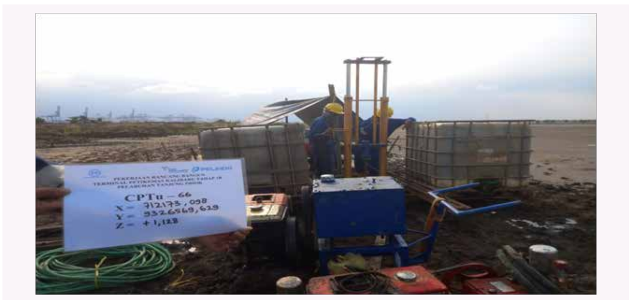
Gambar Pekerjaan Penyelidikan Tanah Kalibaru 1B Kalibaru Land Investigation Work 1B
