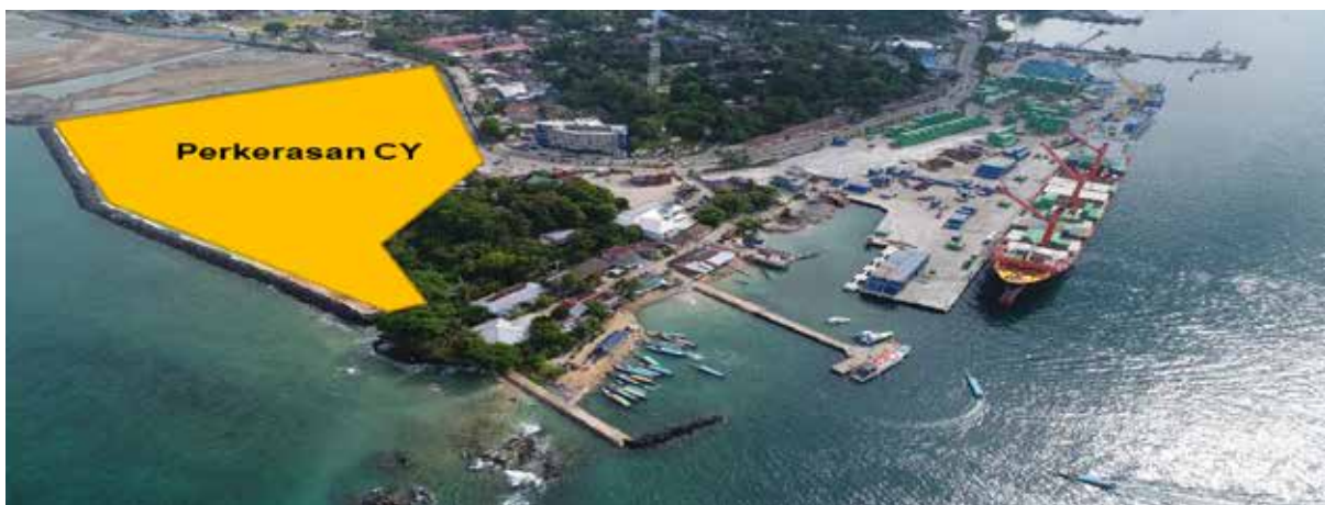
Gambar Dokumentasi Pekerjaan Pelabuhan Sorong dan Arar Sorong and Arar Harbour Works Documentation
