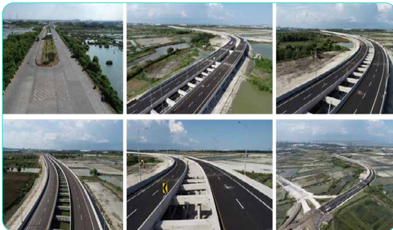
Gambar Dokumentasi Pembangunan Flyover dari dan menuju Terminal Teluk Lamong Construction of Fly Over from and to Teluk Lamong Terminal Documentation
