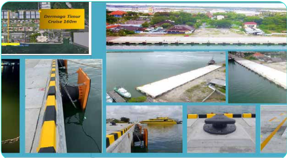
Gambar Dokumentasi Pekerjaan Perpanjangan Dermaga Cruise Sisi Timur 160 m 160 m East Side Cruise Wharf Extension Works Documentation
