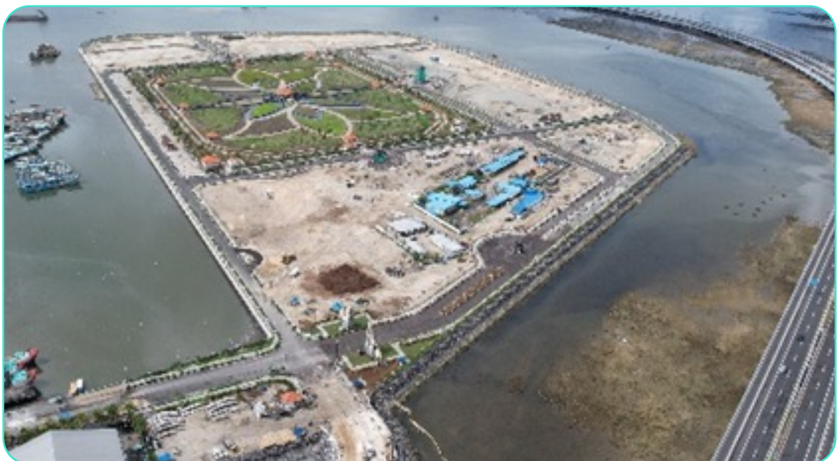
Gambar Dokumentasi Pekerjaan Pembangunan Infrastruktur Dasar Area Pengembangan I Basic Infrastructure Construction Work of Development Area I Documentation
