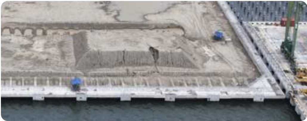
Gambar Pekerjaan Konstruksi Dermaga Pier Construction Work
