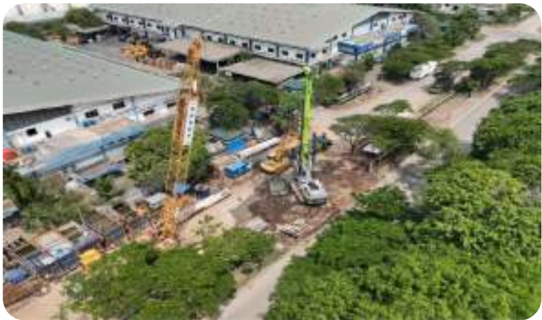
Gambar Pekerjaan Pemancangan Fondasi CSP Area Ramp Utara Marunda Gambar Pekerjaan Pemancangan Fondasi CSP Area Ramp Utara Marunda
