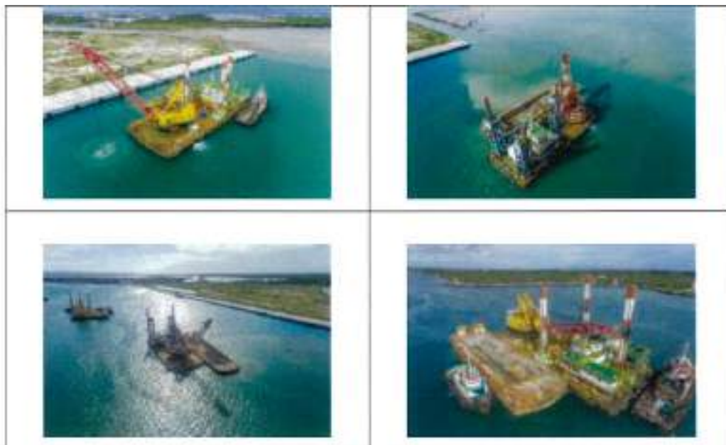
Gambar Pekerjaan Pengerukan di Kolam Dermaga Timur (curah cair, gas, dan petikemas) Dredging Work in the Turning Basin
