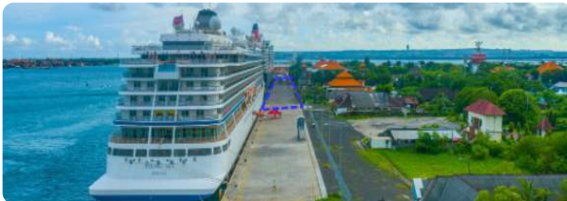
Gambar Lokasi Pekerjaan Perbaikan Dermaga Timur Eksisting 340 M Pelabuhan Benoa Bali Repair Work Location for the Existing 340-meter East Pier at Benoa Port, Bali
